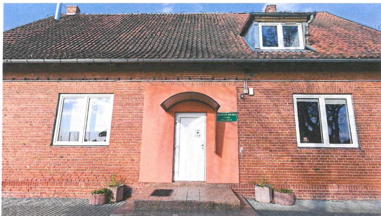
Fot. 3 Schody wejściowe do świetlicy
