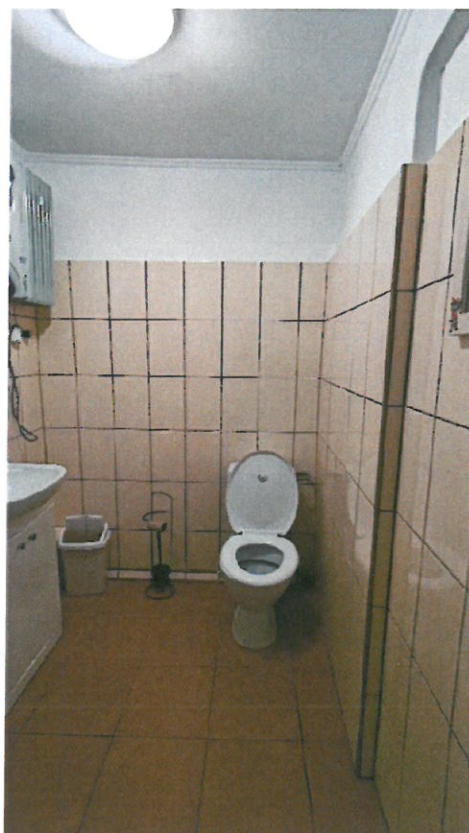
Fot. 6 Pomieszczenie WC
