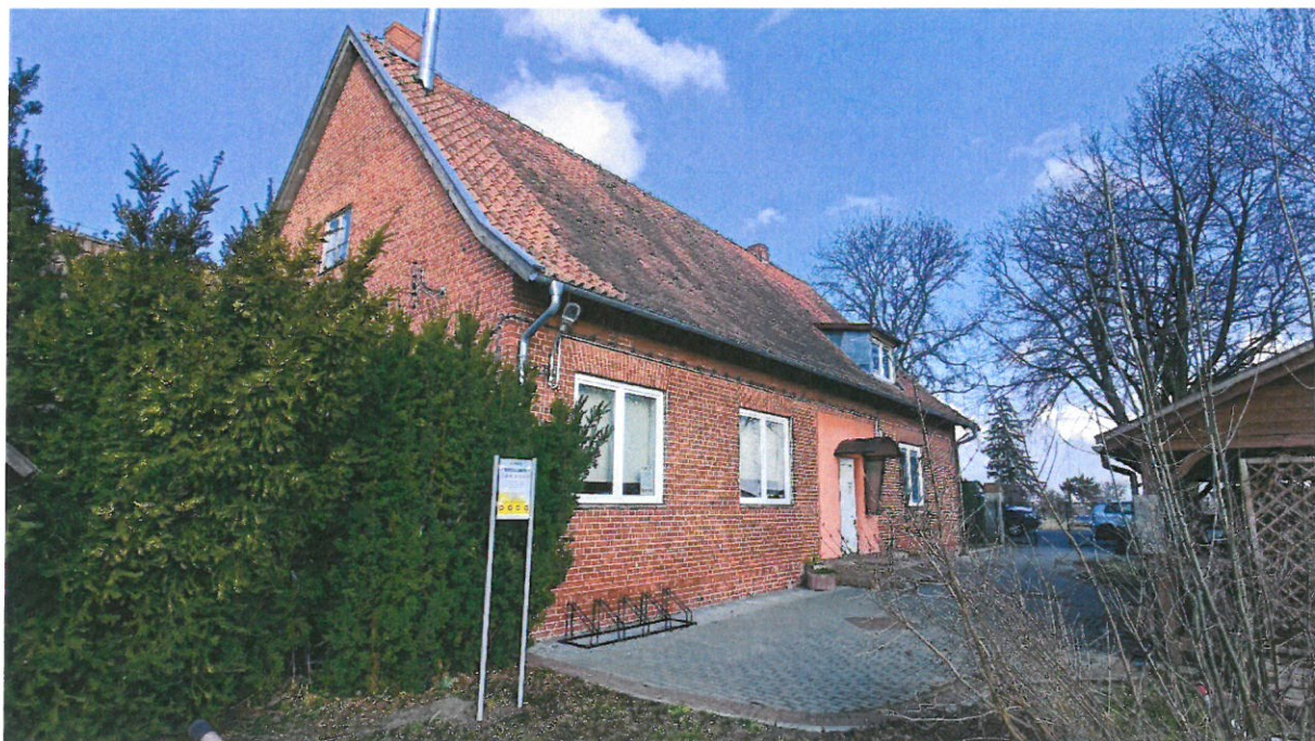
Fot. 2 Elewacja południowo-zachodnia
