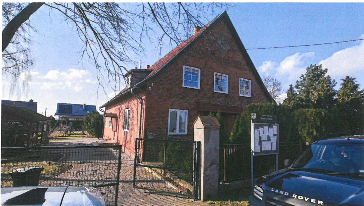
Fot. 1 Elewacja południowo-wschodnia
