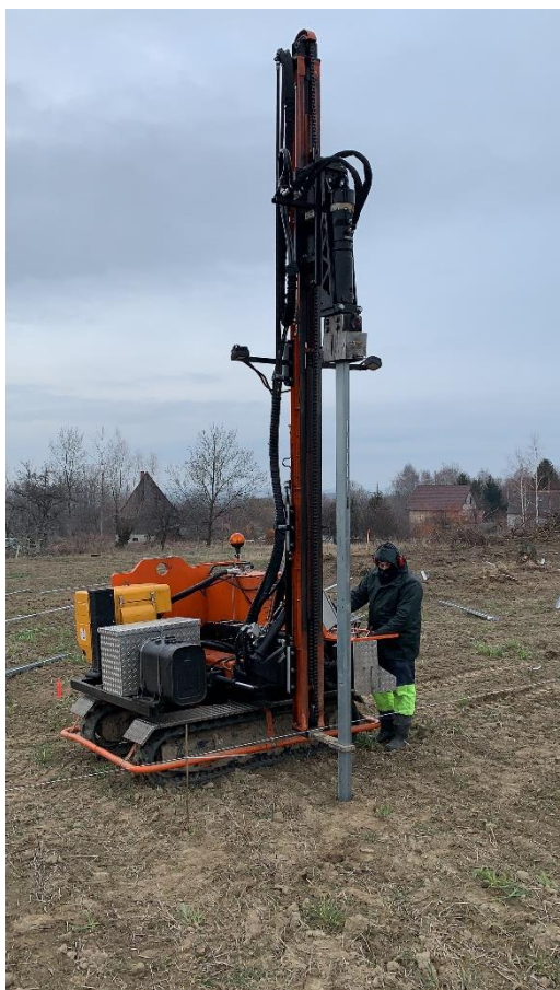
Zdjęcie 2 Przykładowy montaż konstrukcji wsporczej przy użyciu kafara
