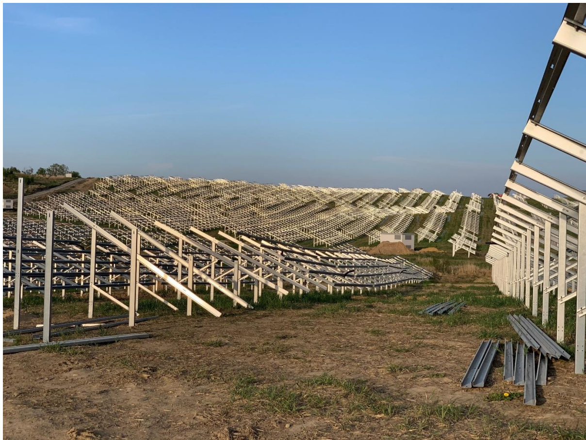
Zdjęcie 3 Osadzone konstrukcje wsporcze pod panele fotowoltaiczne
