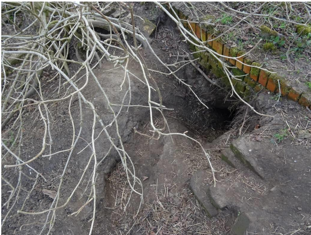
Fot. 13. Nora borsuka obecne w obrębie ruin budynku w buforze inwestycji.
